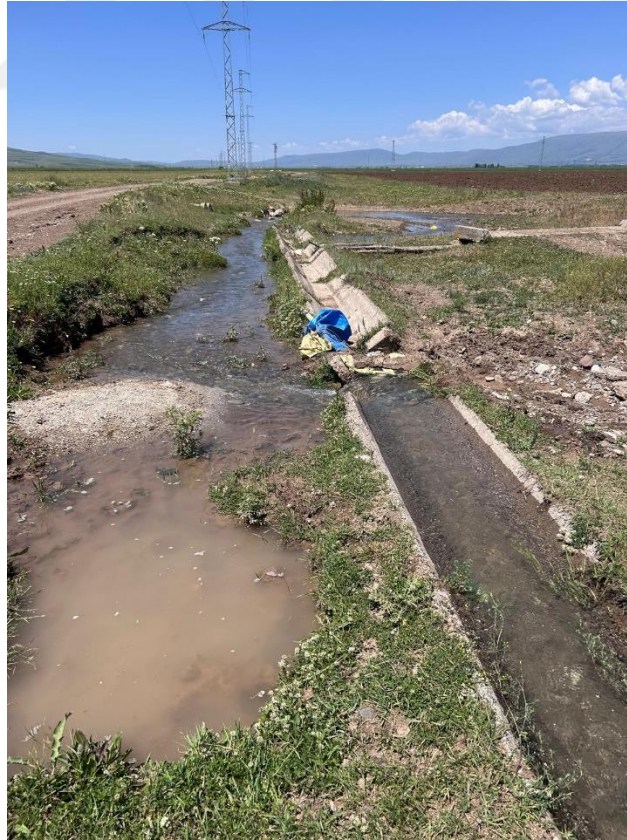
Şekil 11. Bozuk kanal yapısından bir görünüş (Özgün)
