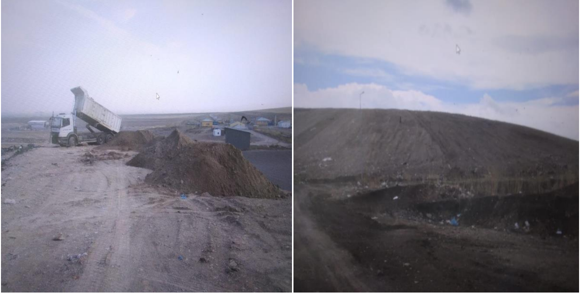
Şekil 27. EKADDT’de 1. Lotun geçici üst örtü ile kapatılması
