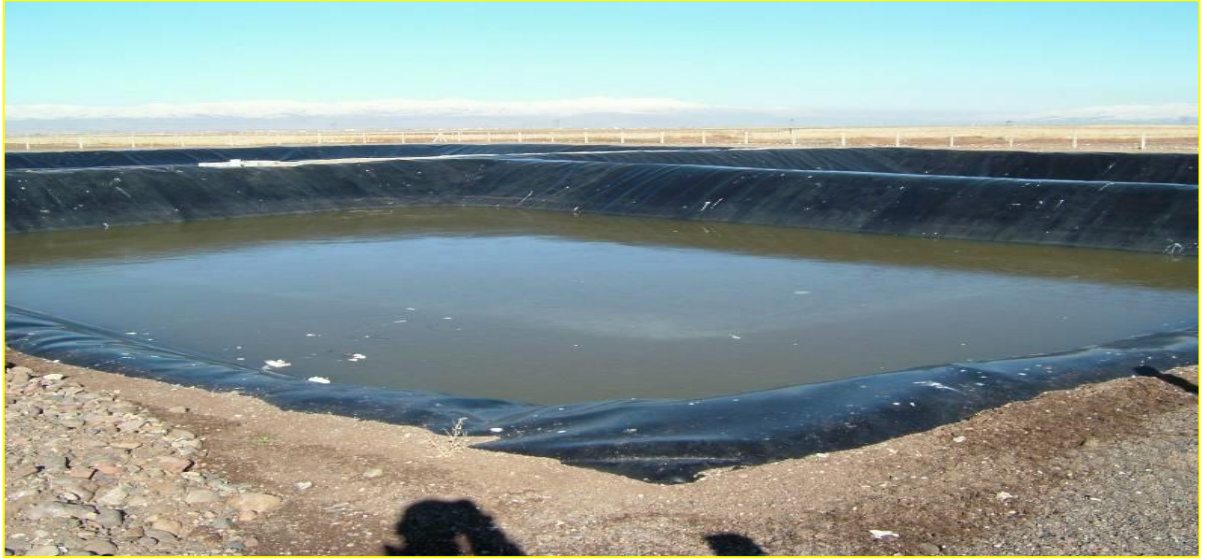
Şekil 24. Sızıntı suyu toplama havuzları
