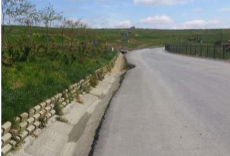
Şekil 10. Yağmur suyu toplama kanalı (Anonim 2014)
