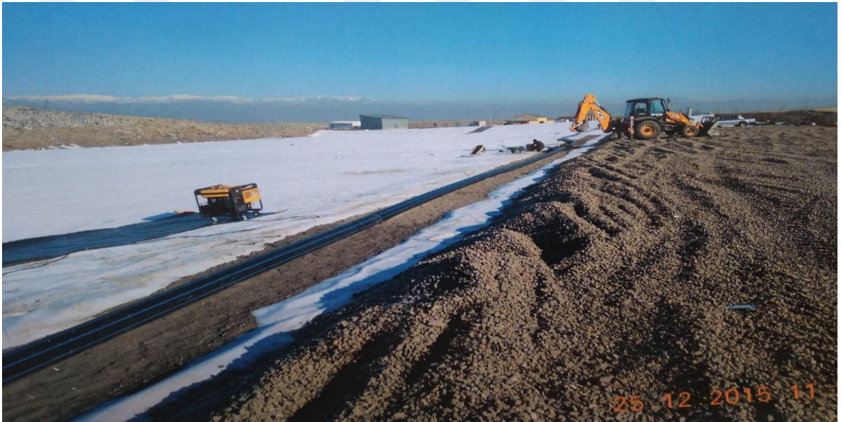
Şekil 43. EKADDT 'de boş hücrelerden yağmur suyu toplam sisteminin yapımı
