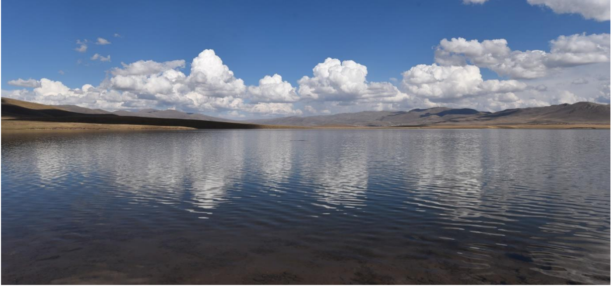
Şekil 11. Erzurum ili ana su kaynağı olan Palandöken Barajı
