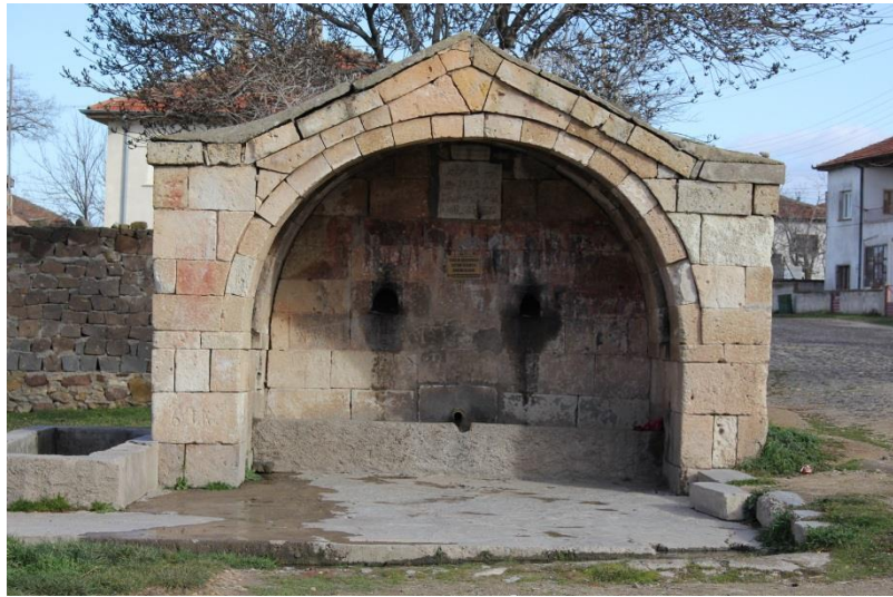
Fotoğraf 99. Hoca Fıkıh Çeşmesi'nden Görünüm
