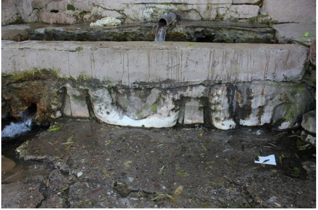
Fotoğraf 106. Akpınar Çeşmesi'nin Su Teknesinden Görünüm
