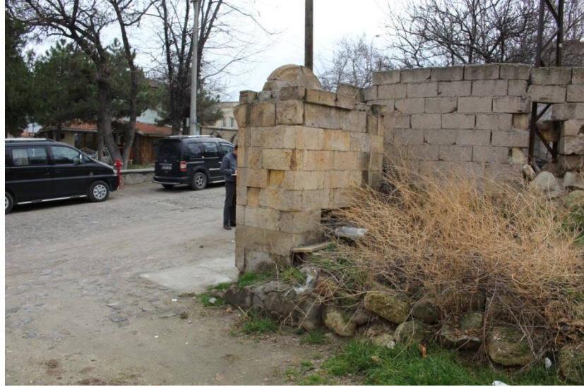
Fotoğraf 164. Ürgüp Okul Önü Çeşmesi'nin Arka Cephesinden Görünüm
