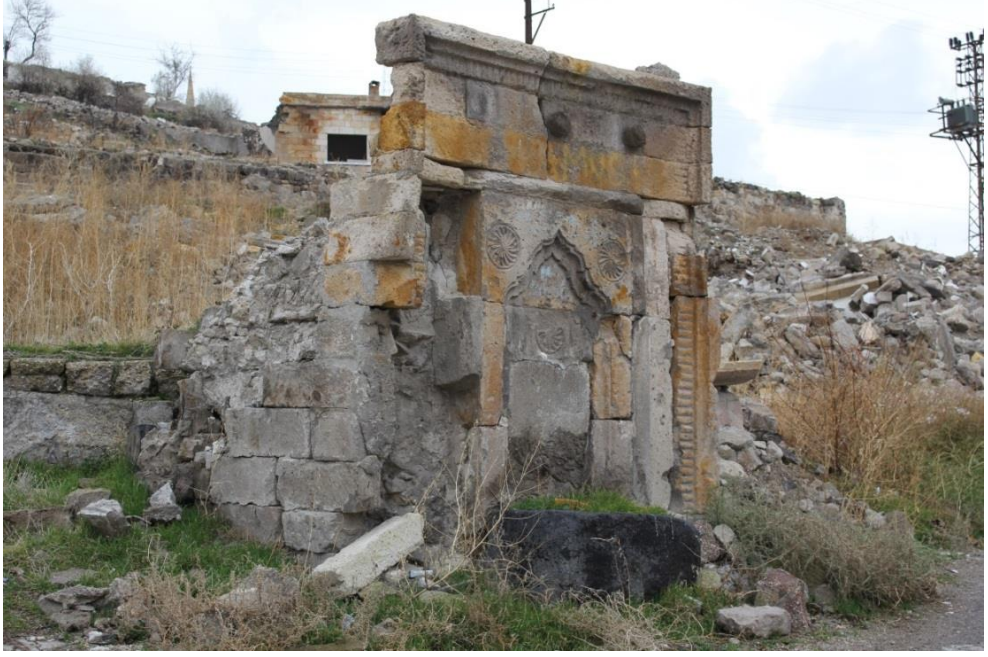
Fotoğraf 47. Tahta Camii Çeşmesi Taşları arasındaki Açılmalar
