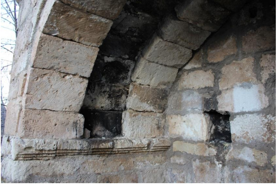
Fotoğraf 111. Hacıbektaş Uç Çeşmesi Kemerinden Görünüm
