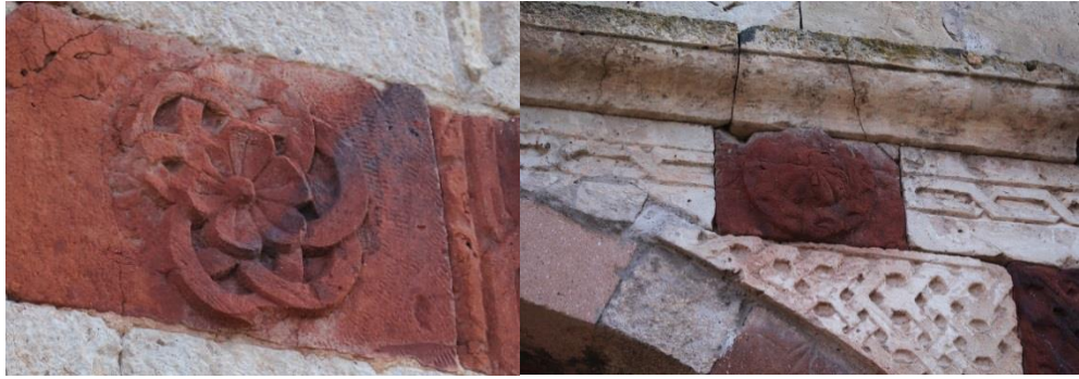
Fotoğraf 135-136. Üçler Çeşmesi Süslemelerinden Görünüm
