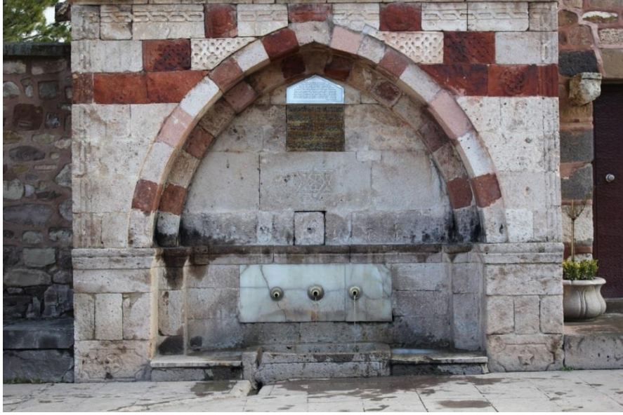
Fotoğraf 131. Üçler Çeşmesi Nişinden Görünüm
