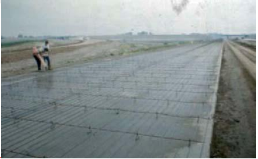
Şekil 1.3. Rijit üstyapı (derzli donatılı)
