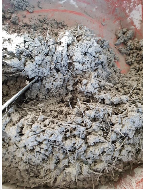
Şekil 3.9. Hazırlanmış beton karışımı
