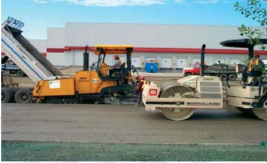
Şekil 1.6. Rijit üstyapı (silindirle sıkıştırılan)
