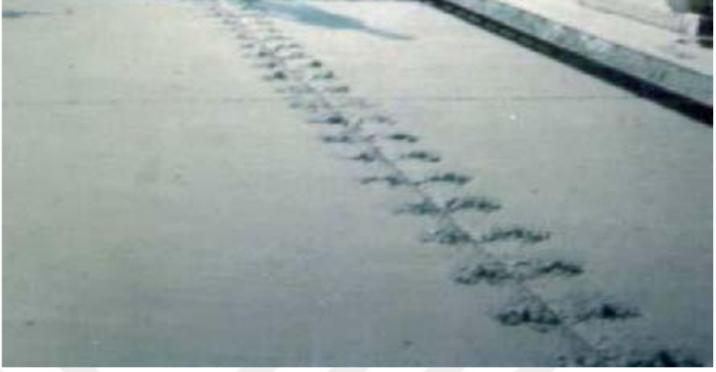
Şekil 1.2. Rijit üstyapı (derzli donatısız)
