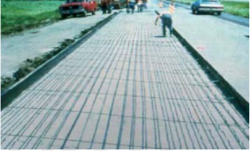
Şekil 1.4. Rijit üstyapı (derzsiz donatılı)
